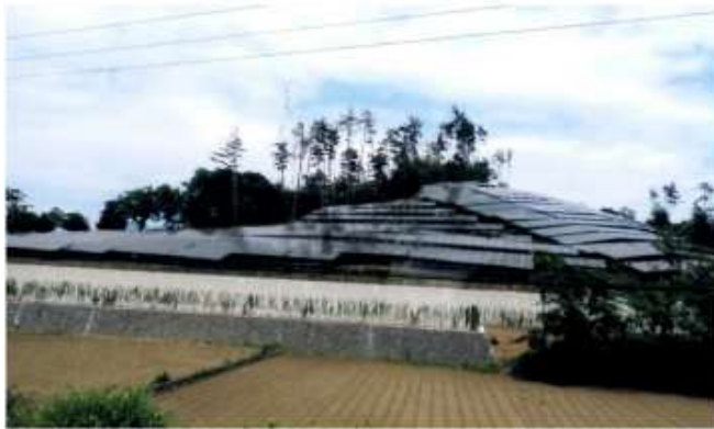
山の上まで設置の太陽光パネル
