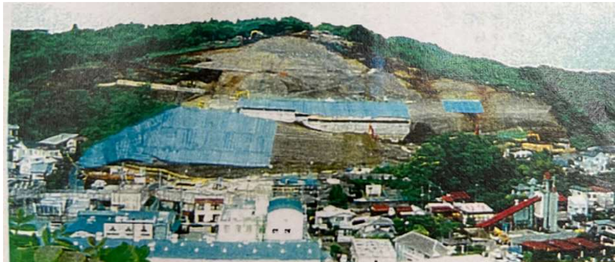
1994年6月工事中の常盤山
