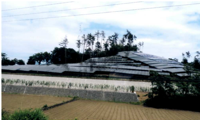
山の上まで設置の太陽光パネル
